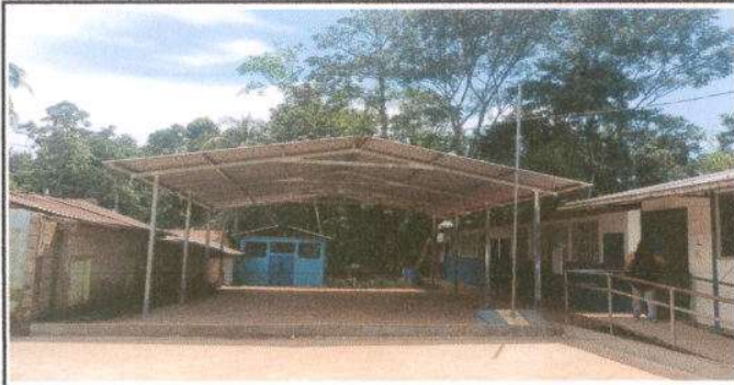
Foto 1: Sustitución de elementos de fijación, capote de lamina
