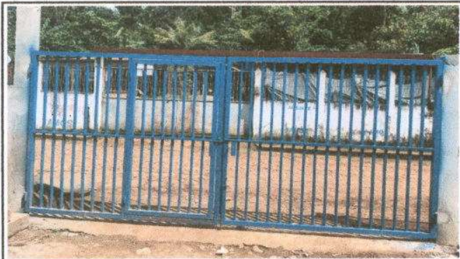
Foto 3 Sustitución de portón por metal
