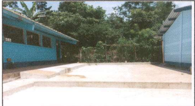
Foto 4: Sustitución de torta de concreto
