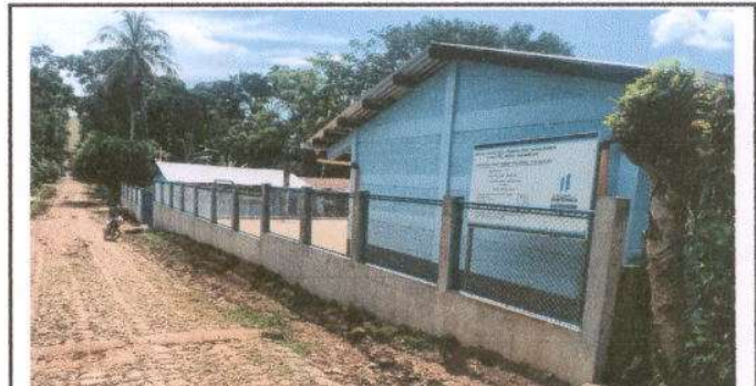
Foto 6: Sustitución de muro perimetral
